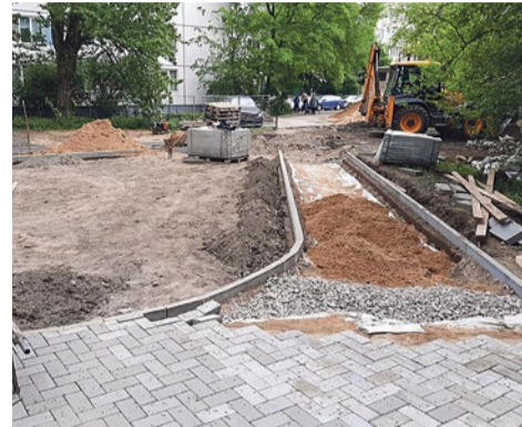
Строительство дорожек на Турку, 32/4
