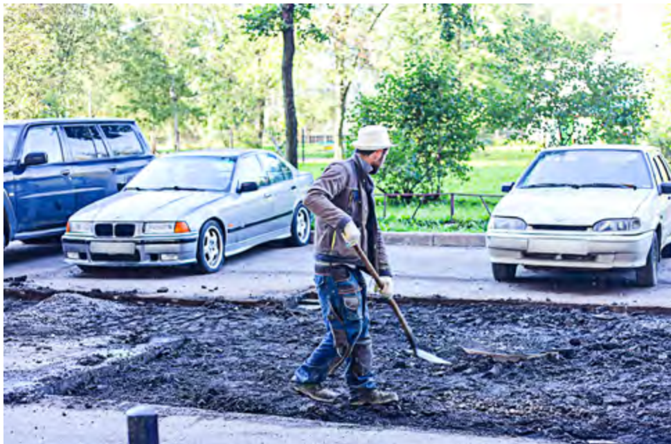
Работы по ремонту асфальтобетонного покрытия на ул. Софийской, 50
