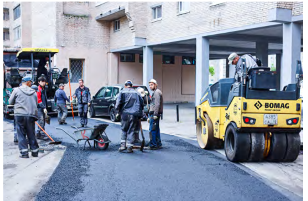
Работы по ремонту асфальтобетонного покрытия на ул. Софийской, 50
