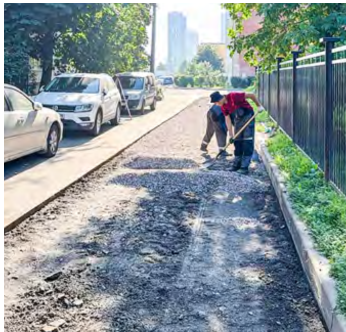
Работы по ремонту асфальтобетонного покрытия на ул. Пражской, 39
