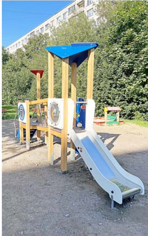
Установка нового игрового оборудования
