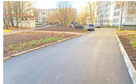
Новое асфальтовое покрытие на внутриквартальной территории по адресу: Белы Куна, 15–17
