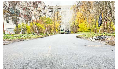
Новое асфальтовое покрытие на внутриквартальной территории
