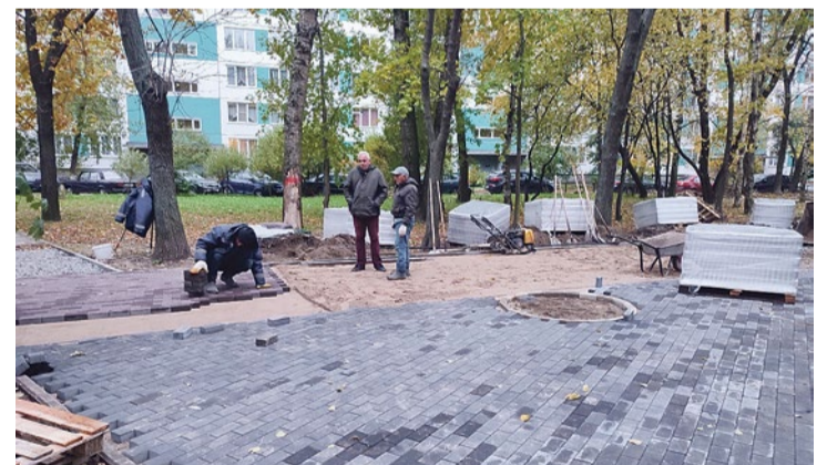
Строительство аллеи на Софийской, 40/1
