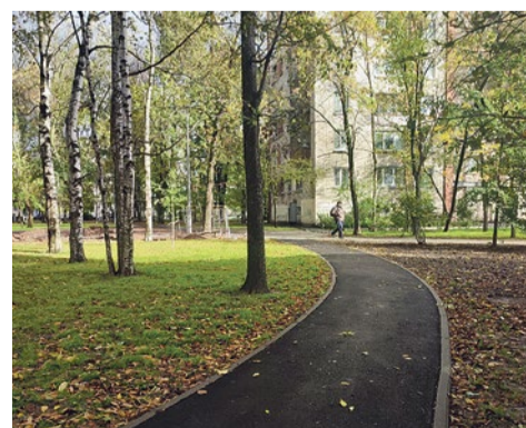
Асфальтирование дорожек на Софийской, 38–40
